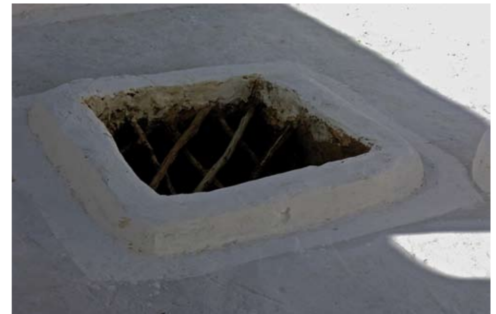
Abb. 117.VI Dachöffnung zur Belichtung und Belüftung des Hauses
