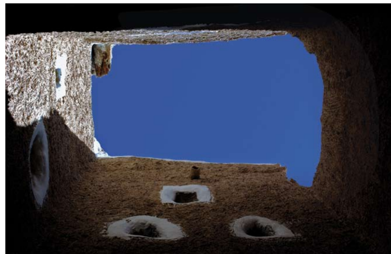
Abb. 113.VI Beleuchtungs- und Belüftungsloch im Dach von einem der Eingänge zu den Straßen der Stadt. Im Öffnungsschacht sieht man einige runde, dreieckige und quadratische Fenster der seltenen Häuser, die sich auf der Außenseite befinden. Aufgenommen im Mai um 17:30 Uhr.
