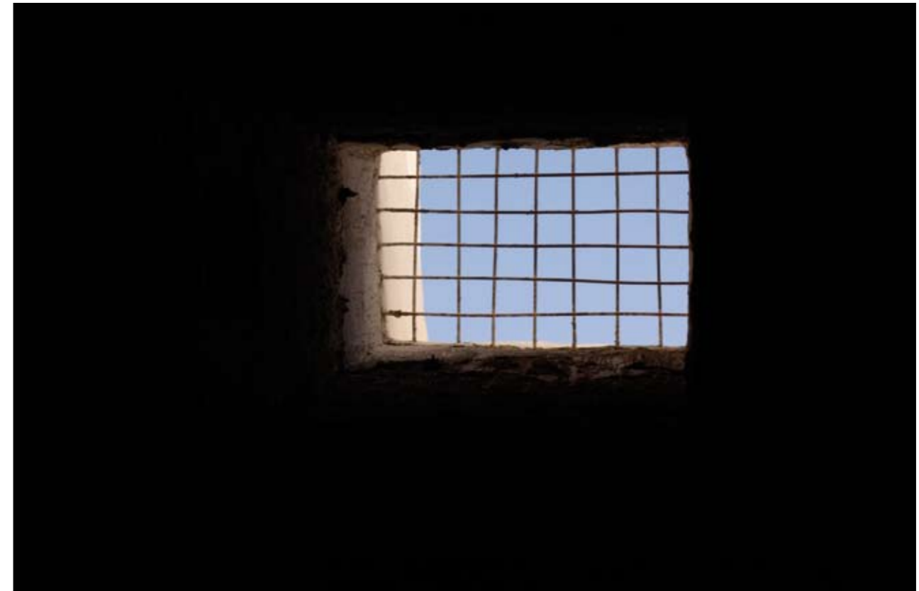
Abb. 108.VI Beleuchtungs- und Belüftungsloch in der Decke und das Metallgitter in einer der Straßen im Monat Oktober um 11:30 Uhr
