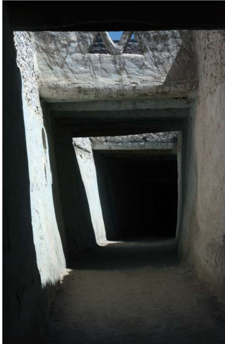
Abb. 70.VI Eine Straße mit zwei nah beieinander liegenden Dachöffnungen. Dabei betont der Lichteinfall die Schrägen der Wand.
