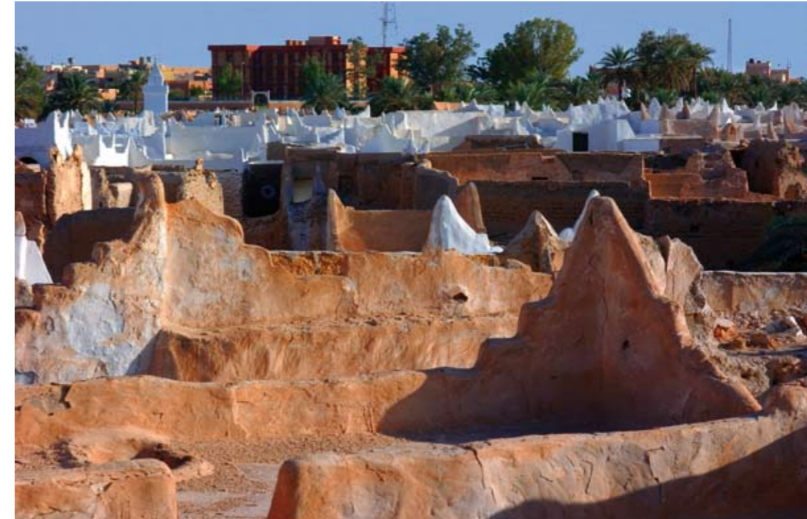
Abb. 58.VI Die Dächer von Ghadames vor und nach der Restaurierung. Im Vordergrund die Dächer mit abgewaschener Farbe; dahinter neu gefasste Dächer und im Hintergrund der Neubau der Stadtverwaltung.
