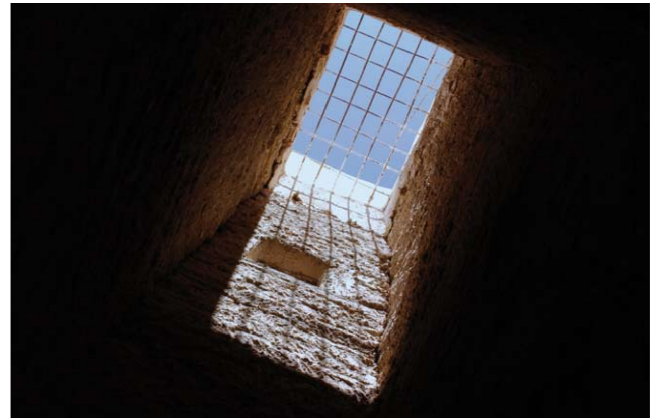
Abb. 109.VI Beleuchtungs- und Belüftungsloch in der Decke in einer der Straßen im Monat Mai um 11:30 Uhr
