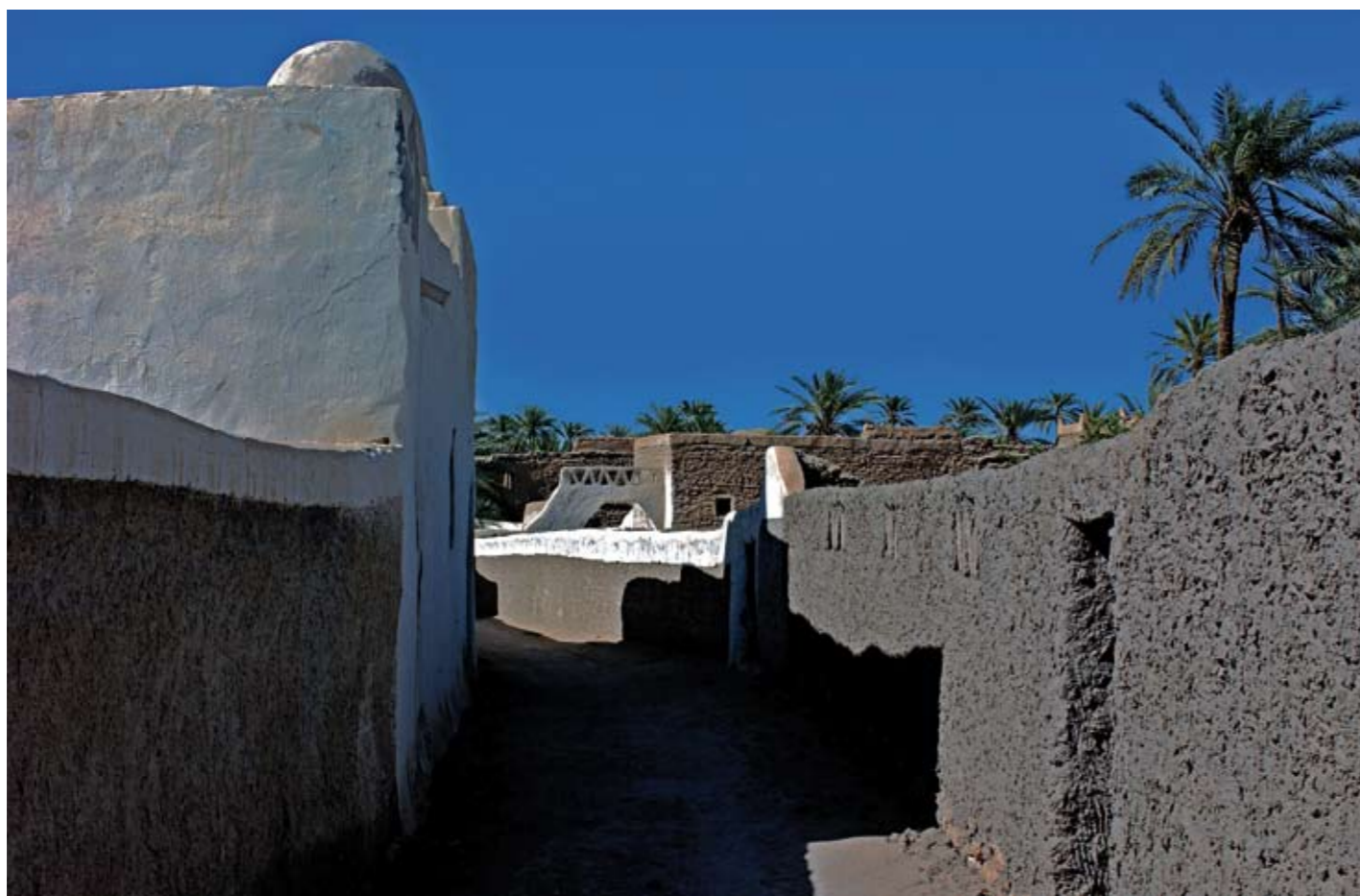
Abb. 160.VI Kuppel über einem Gebäudeblock mit Unterführung Richtung Neustadt
