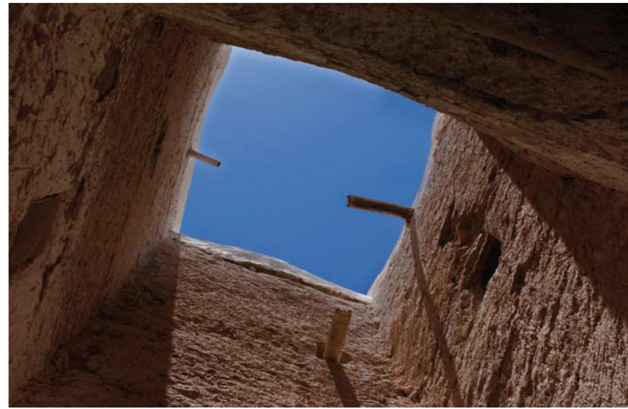
Abb. 112.VI Beleuchtungs- und Belüftungsloch in der Decke in einer der Straßen im Monat September um 13:30 Uhr
