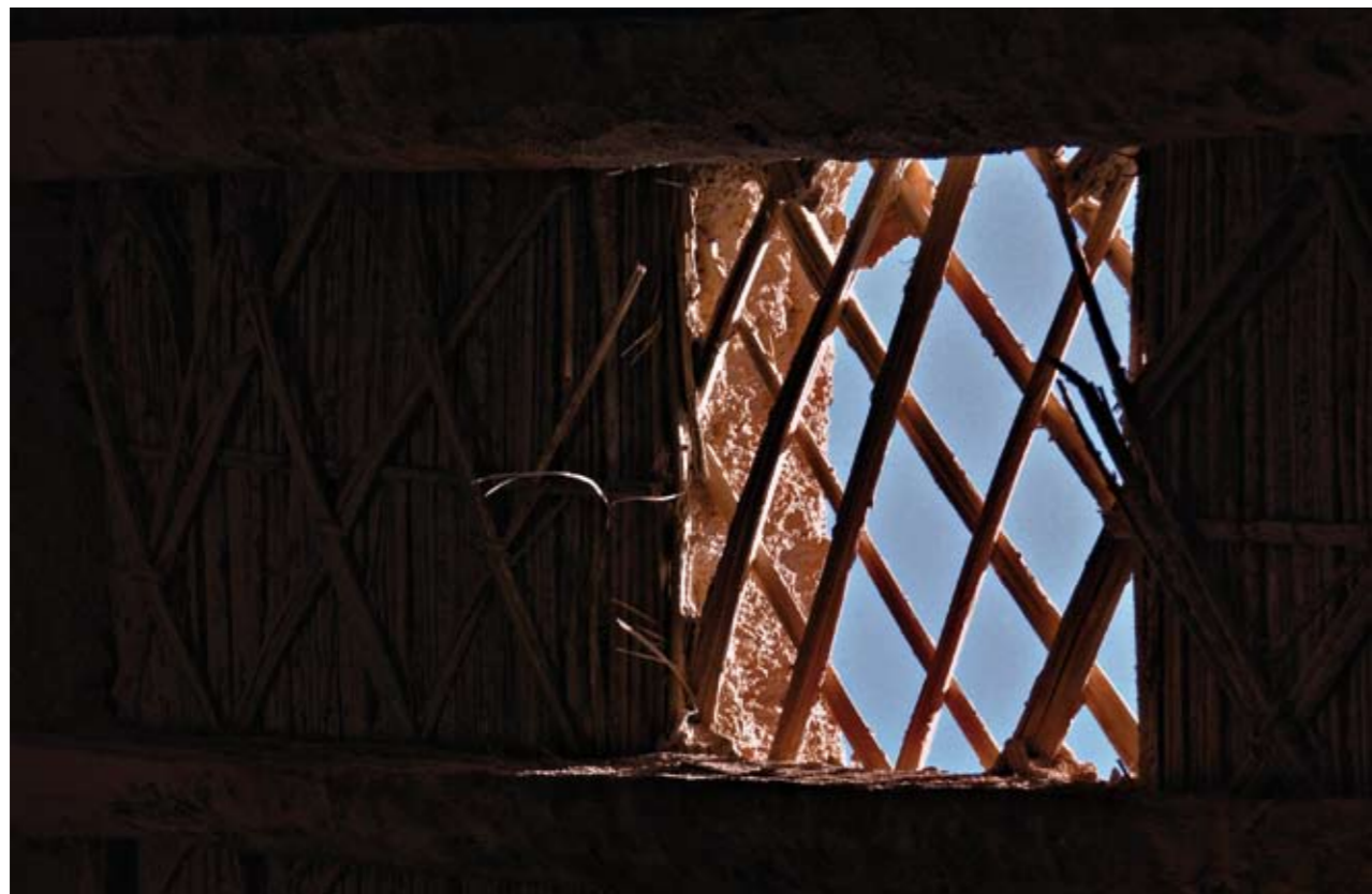
Abb. 111.VI Beleuchtungs- und Belüftungsloch in der Decke und ein Schutz „Essafi“ in einer der Straßen im September um 13:30 Uhr
