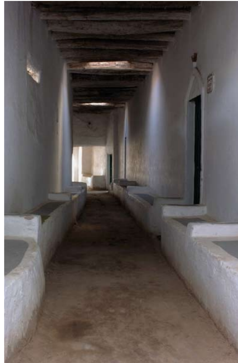
Abb. 131.VI Ratssitze aus Stein, neben der Jonas Moschee, wo die Menschen vor und nach dem Gebet, um sich zu unterhalten, zusammen kommen. Der Gang ist bedeckt von einer Decke aus Palmstämmen, die von Licht- und Lüftungsöffnungen durchbrochen ist.
