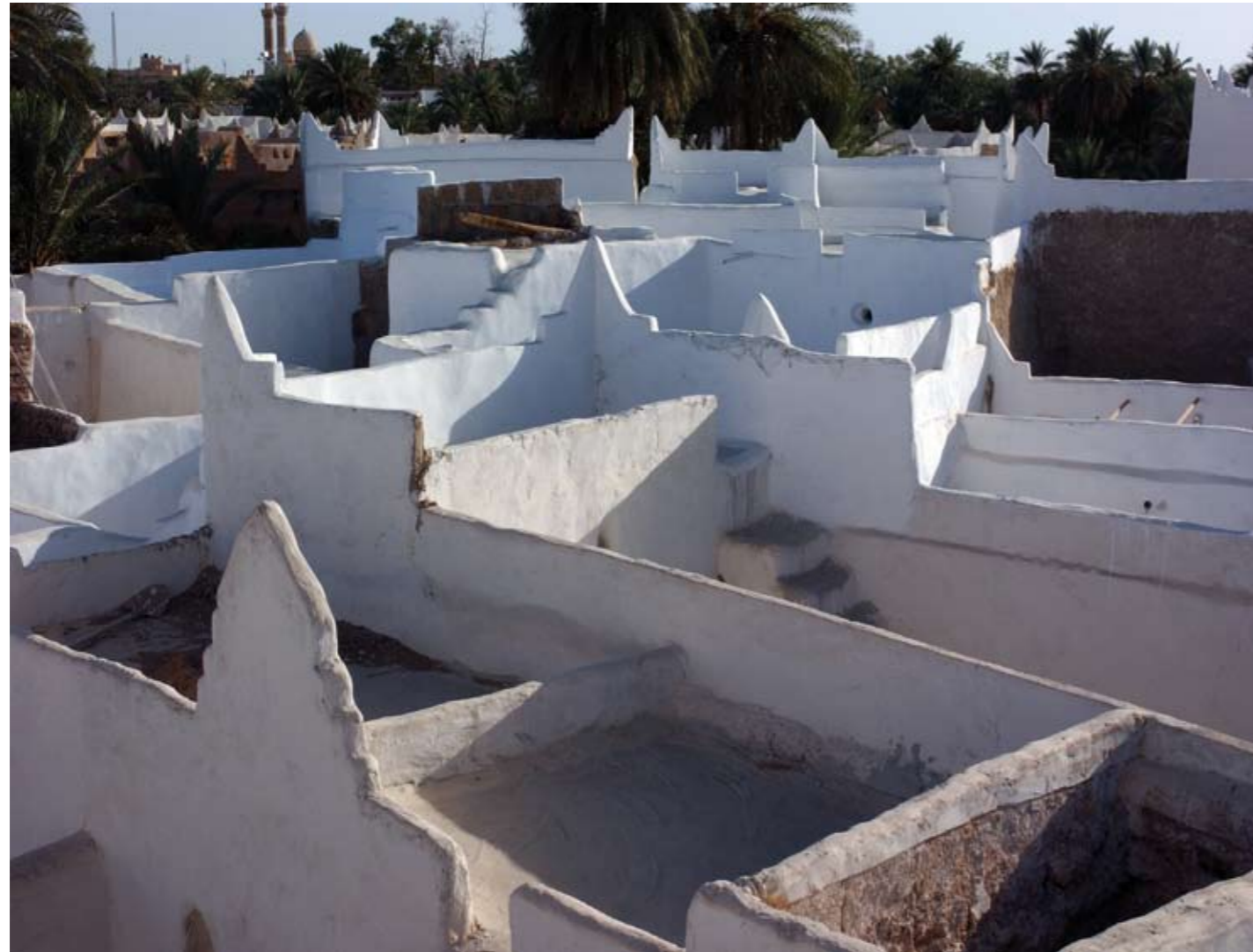
Abb. 60.VI In der Dachlandschaft spiegelt sich der Bauplan der Stadtanlage wider. Treppen führen in Häuser, Dachöffnungen verraten als Licht- und Lufteinlass darunterliegende Gassen und Gänge. Die hier diagonal verlaufenden Linien markieren die Grenzmauern zwischen den Häusern. Diese Überblicksaufnahme entstand von einem erhöhten Standpunkt aus, um die Dachlandschaft mit ihren verschiedenen Ebenen und ihren spitzen Schatten, die durch die Aufbauten gebildet werden, zu verdeutlichen.
