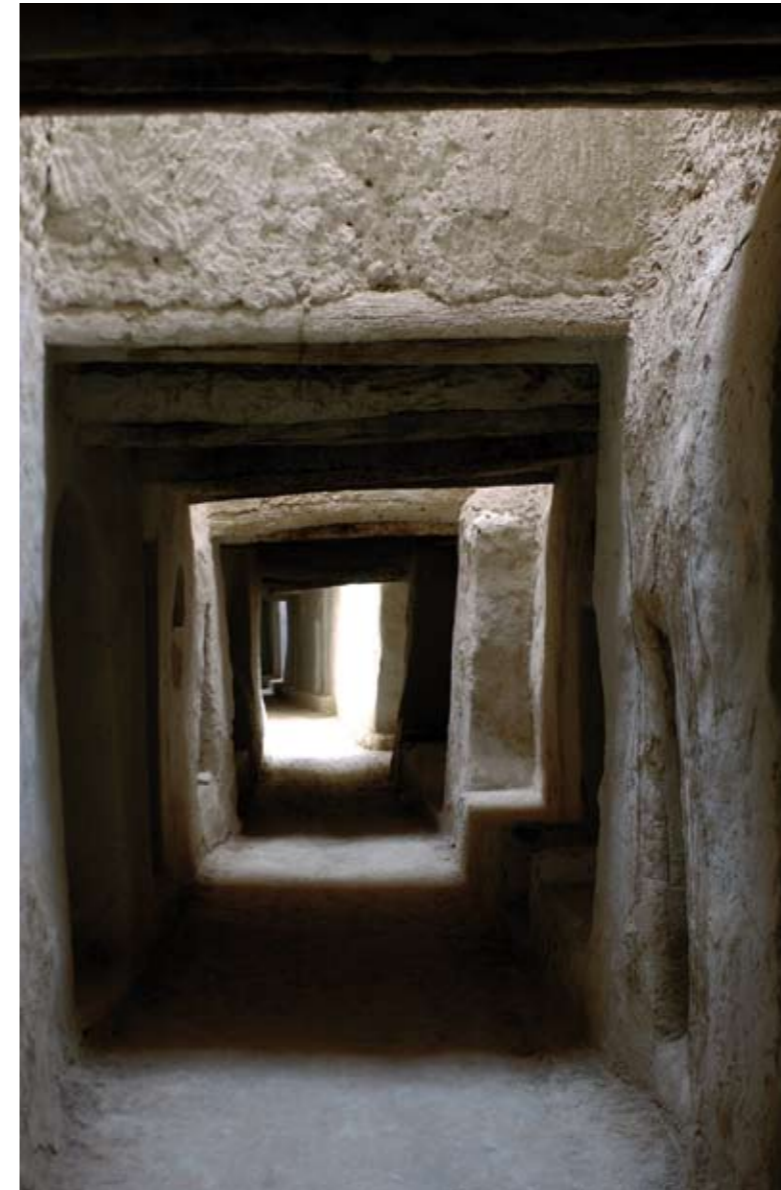
Abb. 69.VI Eine Anmerkung zu den Straßen: die Dachbalken bestehen aus den Stämmen der Palmen und halten, ohne schwächer zu werden, schon Jahrhunderte. Hier sind es die schnell aufeinanderfolgenden Dachöffnungen in einem geschlossenen Gang, die einen rhythmischen Wechsel von Hell und Dunkel erzeugen, der sich im Bild als konzentrische Staffelung zeigt.
