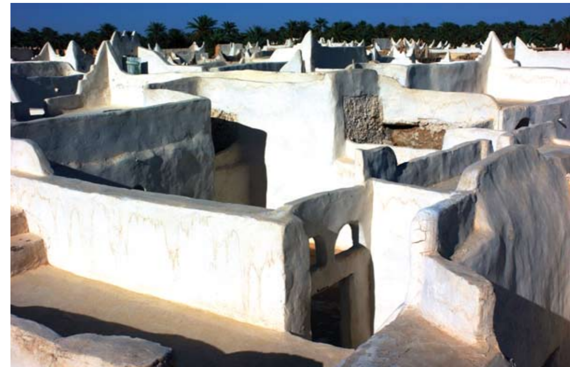
Abb. 59.VI Die Dächer von Ghadames sind charakteristische Elemente einer agglutinierenden Bauweise: einzelne Grundmodule werden zu einem Verbund zusammen geschlossen, variieren aber in der Höhe. Man sieht das deutlich, weil durch die Schlagschatten betont. Hier habe ich eine Perspektive gewählt, aus der man auch die untere Ebene mit ihren Schattenzonen einsehen kann.
