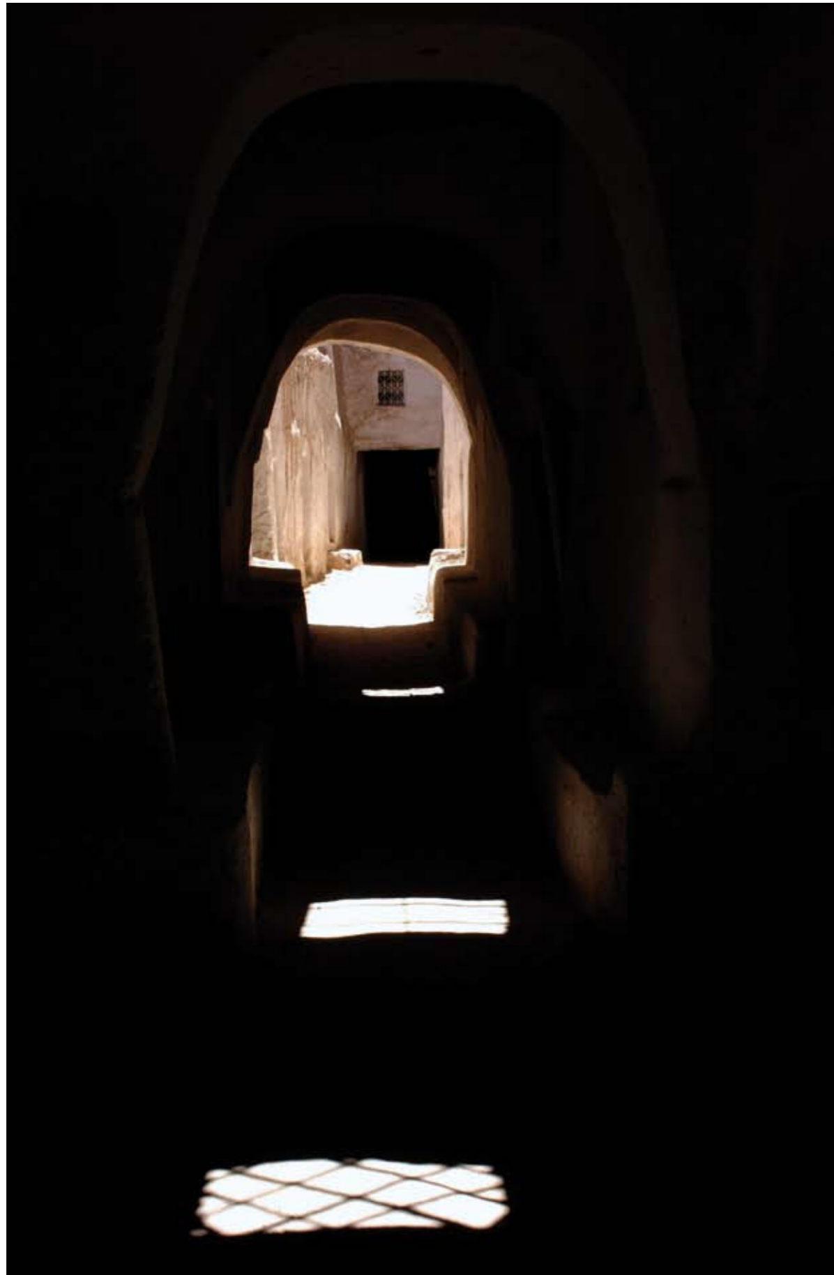
Abb. 84.VI Die Schutzgitter, die über den Öffnungen liegen, geben den Lichtflecken eine geometrische Schattenstruktur.
