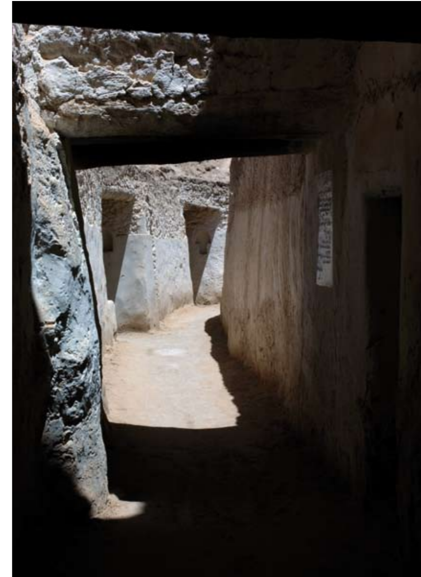
Abb. 75.VI Die Plastizität der Mauer wird hier durch die totale Ausleuchtung betont und steht im Kontrast zu den eher als schwarze Flächen auftauchenden Schattenzonen.
